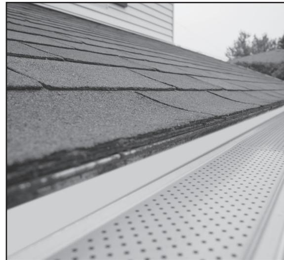
树叶杂物被挡在檐槽上, 经微风一吹即落。树叶即便飘落在檐槽之上也毫不影响排水畅流。
