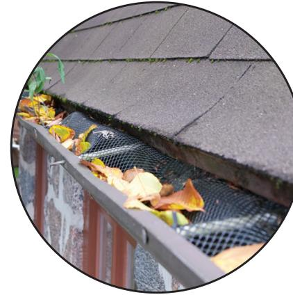
La traforatura dei prodotti Alu-Rex, risultato di test eseguiti su più di un milione di case, è stata concepita per permettere un drenaggio ottimale dell'acqua impedendo il passaggio di qualsiasi detrito.
